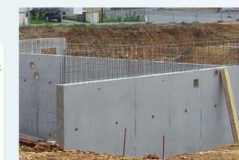
Fer à béton
