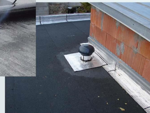
Etanchéité de toits, de terrasses
