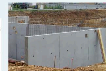
Fer à béton
