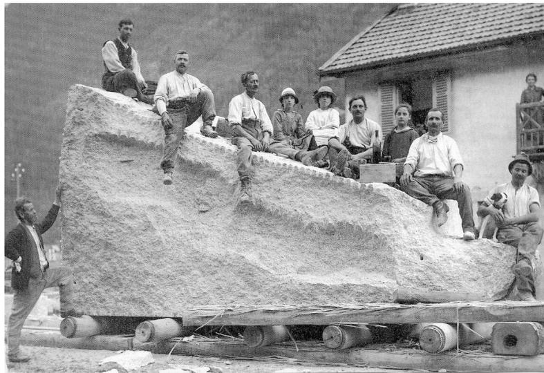
Photo 12. Ce bloc de granit de 40 tonnes et de 6 mètres de long, taillé par l'entreprise Buzzolini, sert de piédestal au monument aux morts de Chamonix.
