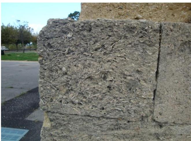
Figure 4- Un bloc de calcaire coquillier sur un des piliers du viaduc du Peyrou.
