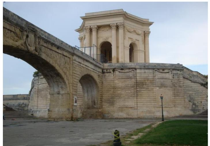
Figure 3- Le Peyrou : viaduc et château d'eau ont été construits, à Montpellier, avec le calcaire de Renaghat.
