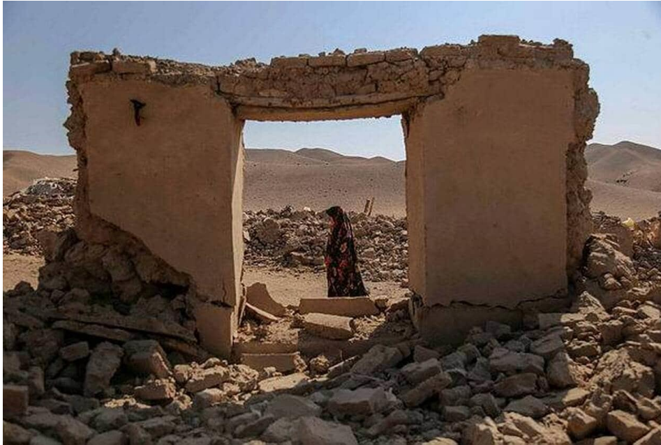
Figure 4. Destructions en Afghanistan, une nouvelle fois touché par de puissants séismes. Les constructions en pisé n'ont pas résisté. Samiullah Popal / EPA-EFE.
