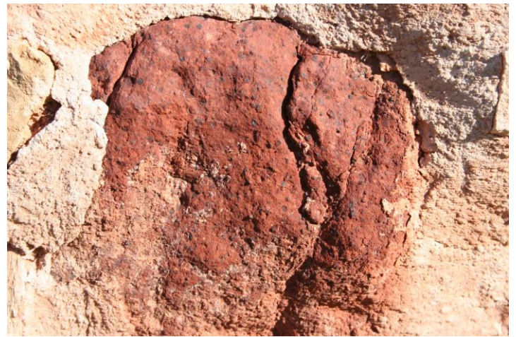
Figure 12. Bauxite dans la maçonnerie de l'abbaye du Thoronet, 2007. Photo J.-M. Labouille.
